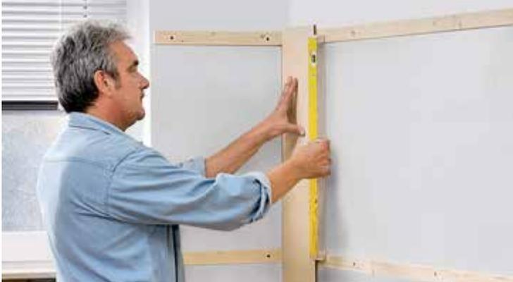
AUF UNTERKONSTRUKTION SCHRAUBEN
